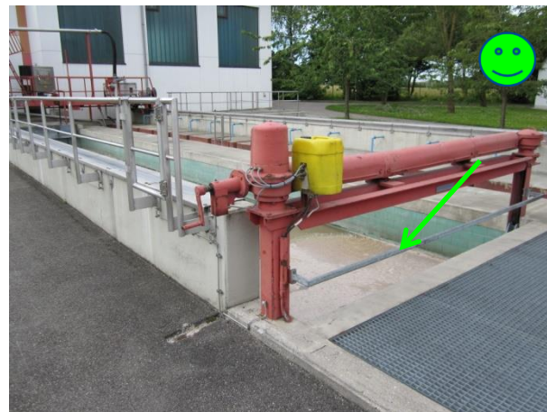
Bild 3.15 nachträglich angebrachte Geländerstange
