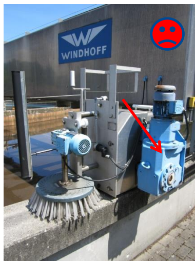
Bild 3.21 Antriebsmotor Laufrad
