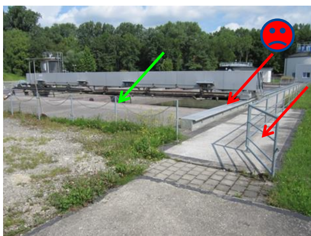
Bild 3.23 Absperrung mit offener Türe
