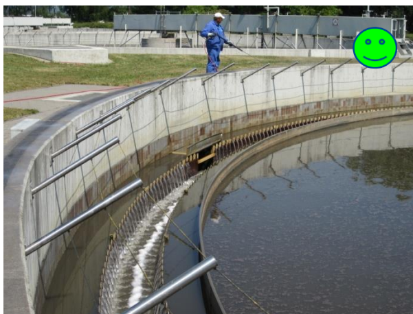
Bild 3.60 Nachklärbecken mit Seilsicherung
