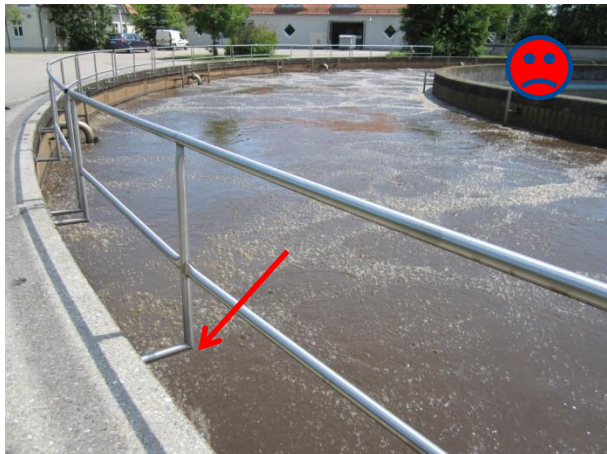
Bild 3.25 fehlende Geländerstange
