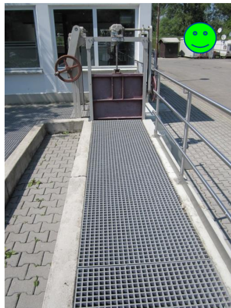
Bild 3.7 Gitterroste als Abdeckung
