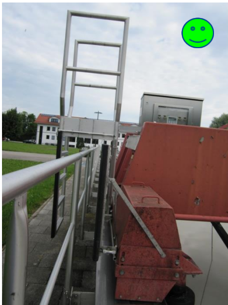
Bild 3.39 Räumer mit Überstieg (Längsbecken)
