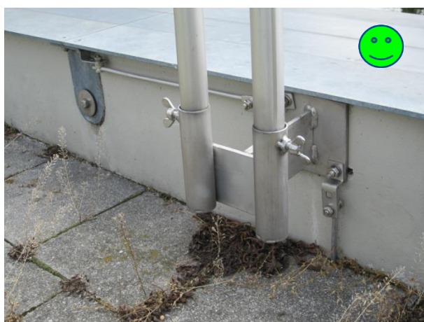
Bild 3.33 Steckvorrichtung zum Festschrauben
