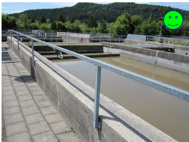
Bild 3.14 Geländer am äußeren Beckenrand
