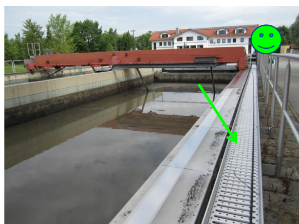
Bild 3.42 Blech als Kabelführung
