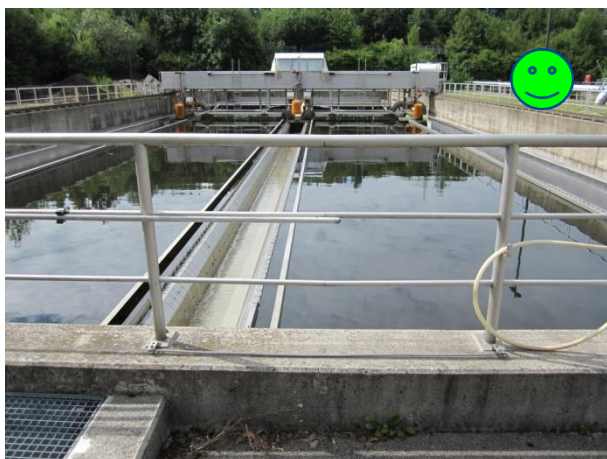
Bild 3.18 Geländer als Absturzsicherung (1,10 m Höhe)
