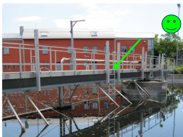
Bild 3.28 Notausstieg über Räumerverbrücke
