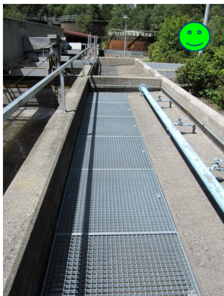
Bild 3.6 Gitterroste als Abdeckung
