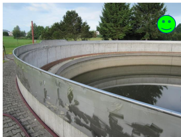
Bild 3.62 mit Blech erhöhter Beckenrand
