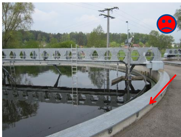
Bild 2.4 ungesichertes Nachklärbecken
