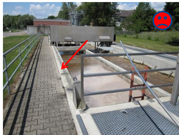
Bild 3.24 Geländer als Absperrung
