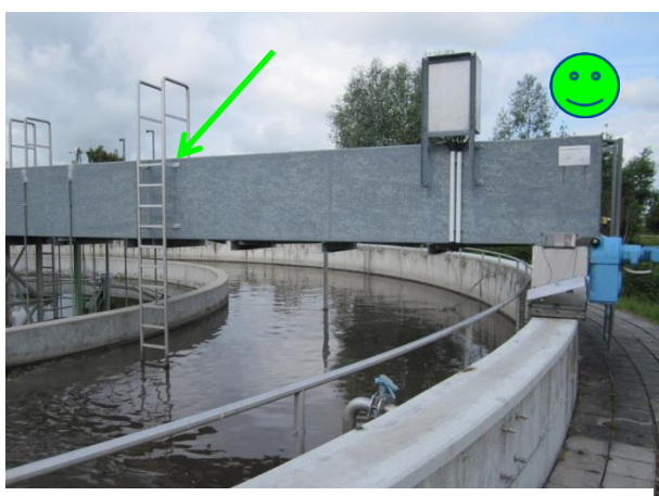
Bild 3.27 Notausstieg über Räumerverbrücke
