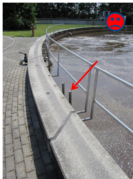
Bild 3.26 kaum nutzbarer Notausstieg
