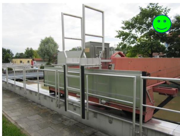
Bild 3.38 Überstieg mit beidseitiger Kontaktleiste
