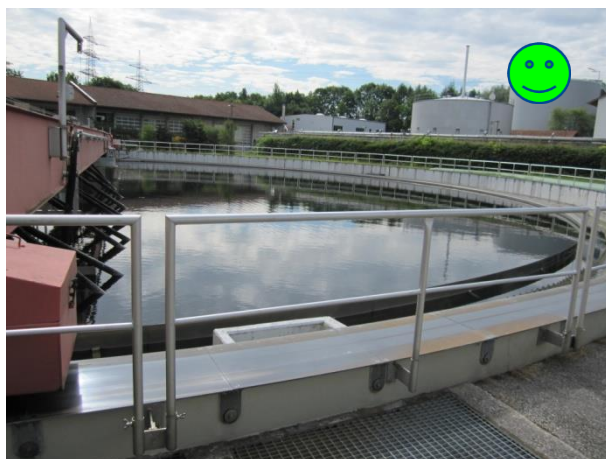
Bild 3.31 Steckgeländer am Rundbecken
