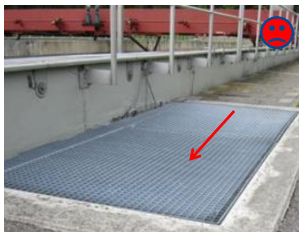
Bild 3.5 leicht durchgebogener Gitterrost
