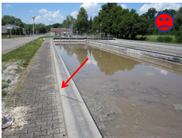
Bild 2.3 ungesichertes Sandfangbecken
