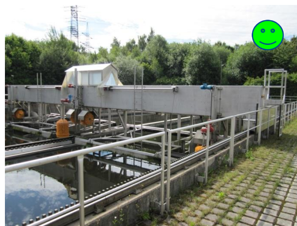
Bild 3.32 Steckgeländer am Längsbecken
